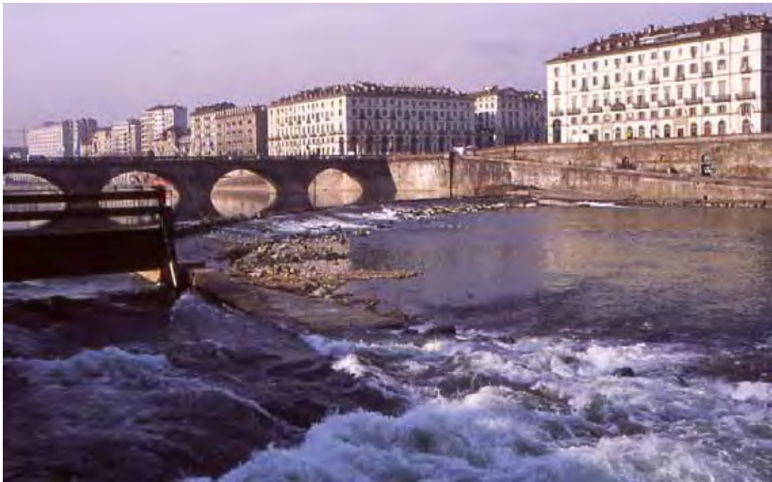
Fig. 13 - Il Po a Torino ai Murazzi. Si osservi la sponda cementificata e l'assenza di una fascia di vegetazione perifluviale in sponda idrografica sinistra
