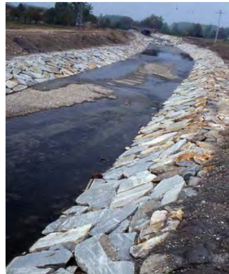
Figura 6 - A sinistra un corso d’acqua ricco e diversificato. A destra lo stesso dopo un intervento di sistemazione idraulica. Un ecosistema fluviale è stato trasformato in un canale privo di vita ed idrogeologicamente più pericoloso: aumenta la velocità di corrente dell’acqua di piena (ed anche l’energia erosiva), meno ostacolata nel suo fluire verso valle.
