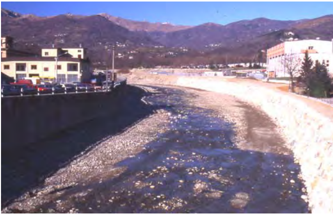
Figura 5 - Per proteggere le case, le sponde sono state “sistematiche” con pareti lisce, per diminuire la loro capacità di opporsi, per attrito, al flusso dell’acqua. Ma la corrente, durante le piene, diventa più veloce e più pericolosa, verso valle, per l’incremento della energia erosiva.
